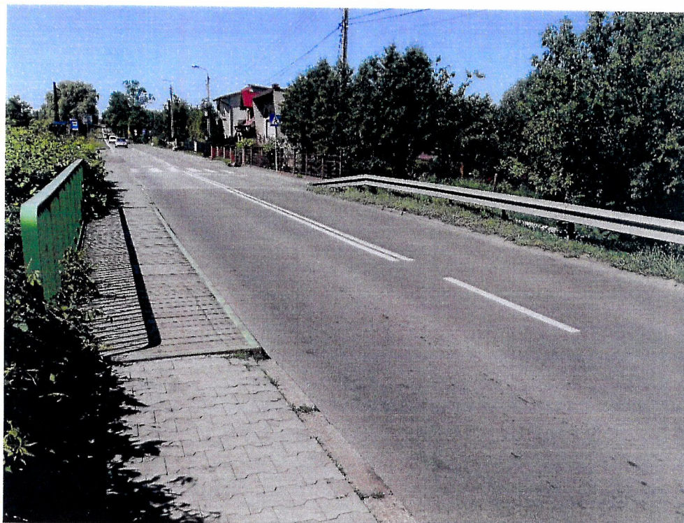
Fot. 1. Widok ogólny od strony ul. Głównej.
