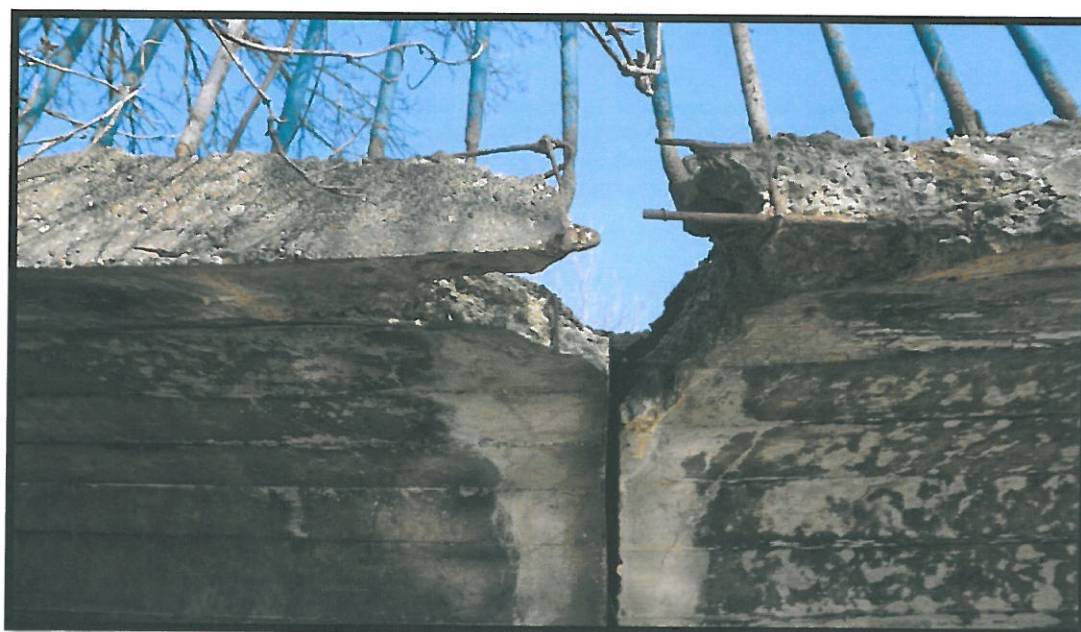
Fot. 13 Uszkodzenie jak wyżej. Dodatkowo widoczne zacieki, osady, wykwyty na spodzie ustroju nośnego wynikające z całkowitej nieuszczelnności przerwy dylatacyjnej.
