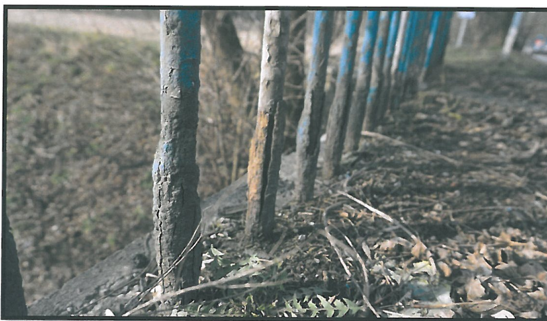
Fot. 17 Widoczne miejscowe, całkowite zniszczenie zabezpieczenia antykorozyjnego elementów balustrady oraz bardzo głęboka korozja stalowych przekrojów. Uszkodzenie spowodowane naturalnym zużyciem elementów balustrady, dodatkowo narażonych na działanie soli odladzającej stosowanej w okresie zimowym. Zaleca się wykonanie kompleksowego remontu balustrady poprzez wymianę istniejącej balustrady na nową.
