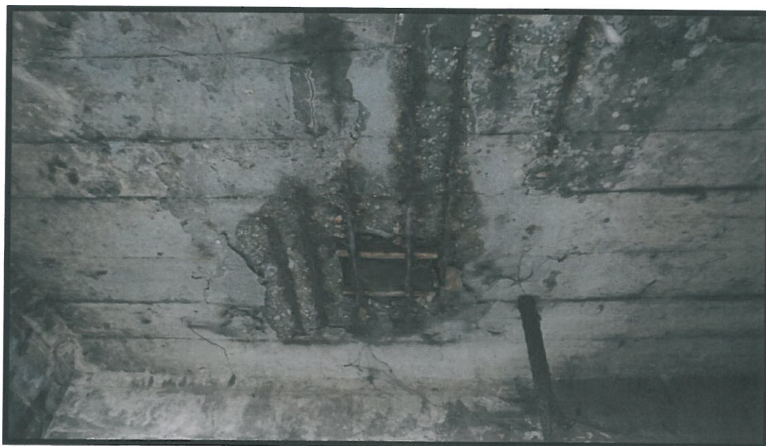
Fot. 27 Widoczne duże ubytki betonu, odsłonięte skorodowane zbrojenie, zacieki, osady, wykwyty na płycie ustroju nośnego. Uszkodzenia są wynikiem przede wszystkim brakiem szczelnej izolacji.
