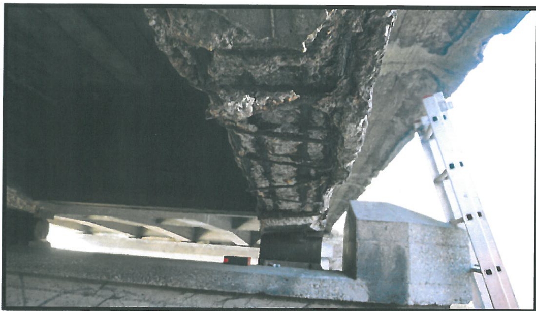
Fot. 24 Wspornik od strony Sosnowca: Uszkodzenie jw. Rozległa i głęboka korozja betonu i stali zbrojeniowej w strefy ściskanej dźwigara zmniejsza wysokość użytkową przekroju nawet o 15cm, co prowadzi do dużego spadku jego nośności. Zaleca się wykonanie szczelnej izolacji oraz dylatacji, a następnie wykonanie naprawy powierzchniowej wraz z wzmocnieniem dźwigarów i poprzecznic na obu wspornikach mostu.
