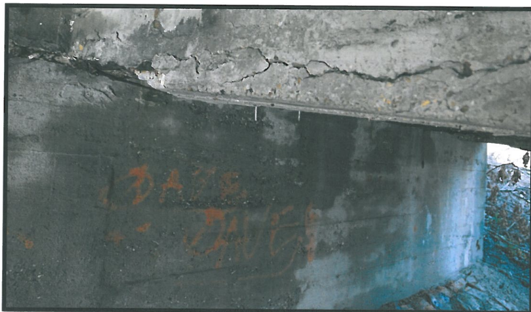
Fot. 26 Przyczółek od strony Katowic: Widoczne rozległe zanieczyszczenia graffiti oraz zacieki na ścianie żelbetowej przyczółka na którym nie jest oparty ustroju nośny. Uszkodzenia są wynikiem przede wszystkim brakiem szczelności styku dylatacyjnego na końcu wspornika mostu.
