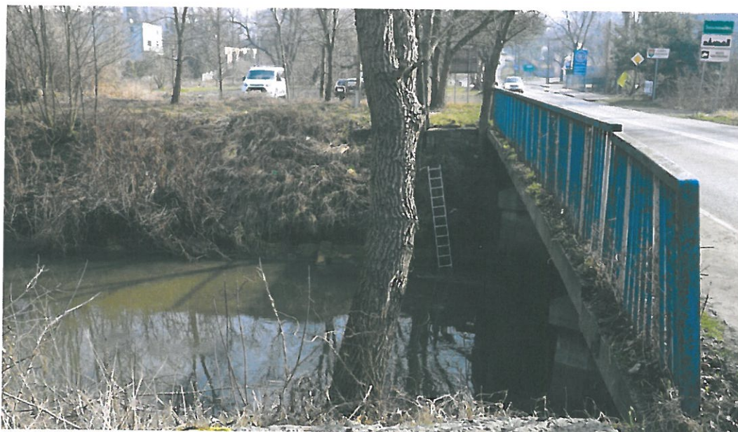
Fot. 34 Na zdjęciu widoczna pojedyncze drzewo rosnące w bliskim sąsiedztwie konstrukcji mostu. Rosnące korzenie i konary drzew powodują destrukcyjne działanie na elementy konstrukcji ustroju nośnego, podpór oraz elementów wyposażenia i skarp.
