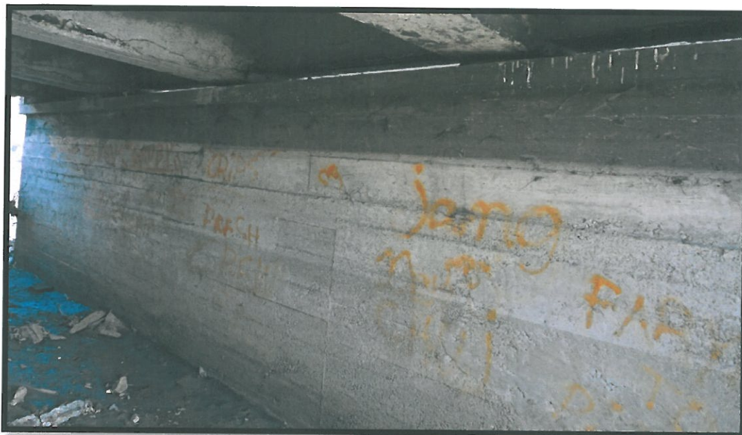
Fot. 30 Widoczna zanieczyszczenia w postaci graffiti na ścianie podpory pośredniej od strony Katowic spowodowane wandalizmem. Zaleca się oczyszczenie powierzchni betonowej z graffiti.
