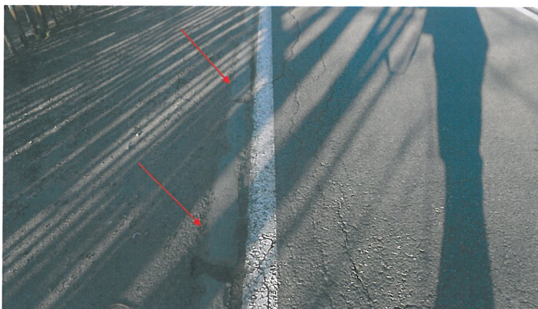
Fot. 11. Na zdjęciu krawężnik całkowicie zabudowany w warstwie asfaltu z widoczną jedynie górną powierzchnią na całej długości pobocza od strony południowej. Krawężnik całkowicie nie spełnia swojej funkcji, nie zabezpiecza zjazdu samochodu z jedni na chodnik (pobocze). Docelowo zaleca się wykonanie bariery zabezpieczającej lub reprofilację linii krawężnika.
