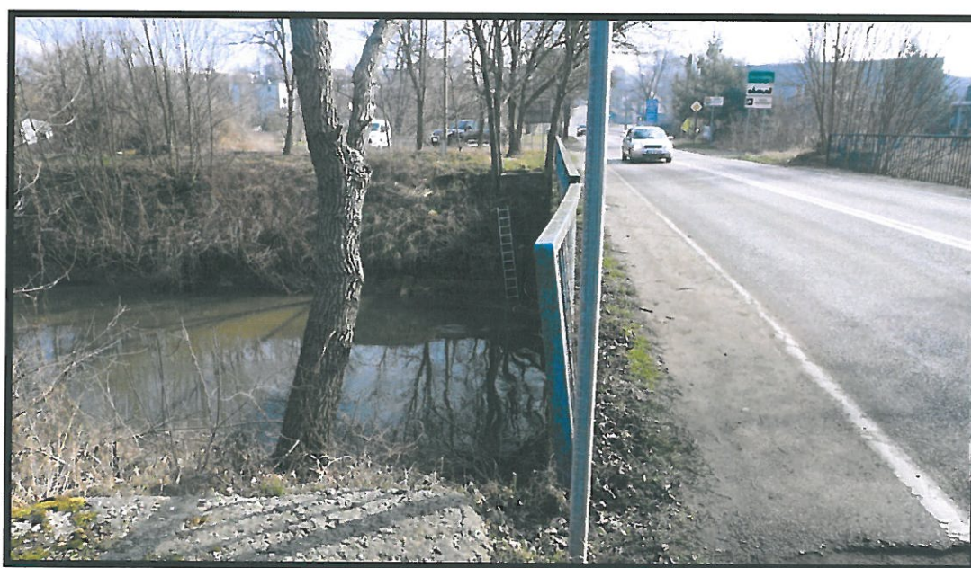
Fot. 15 Miejscowa deformacja balustrady stalowej od strony Katowic (strona północna) w stosunku do położenia pierwotnego. Balustrada wykazuje dużą podatność na odkształcenia.
