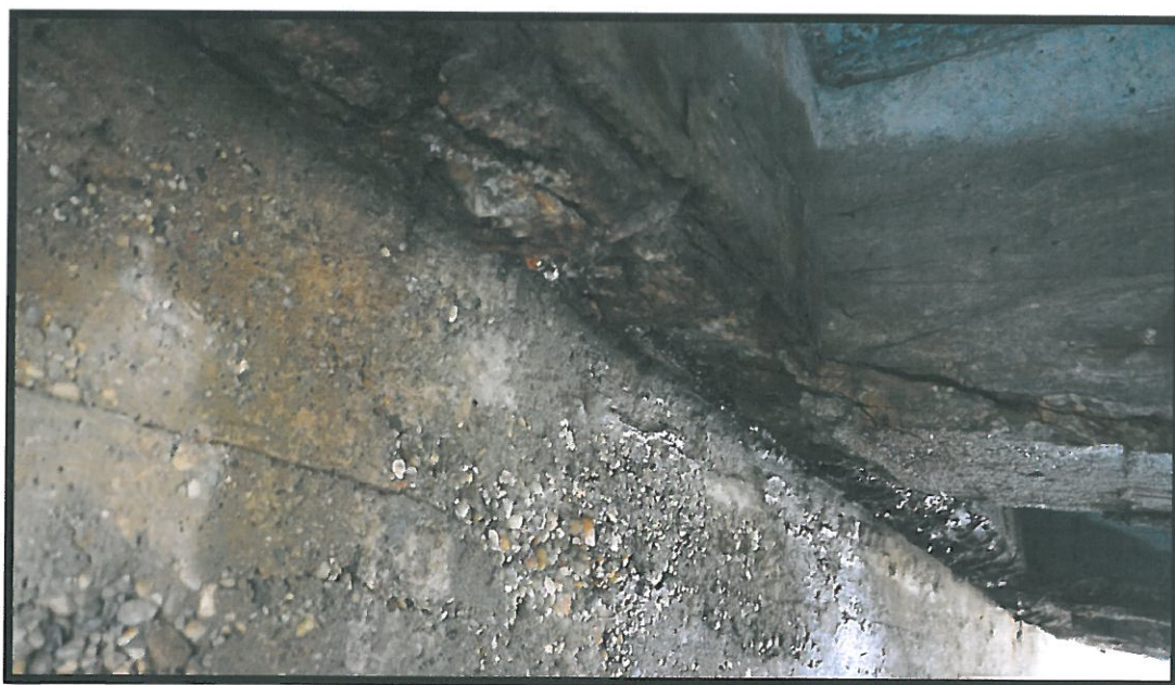
Fot. 25 Przyczółek od strony Sosnowca: Widoczne rozległe zacieki na ścianie żelbetowej przyczółka na którym nie jest oparty ustroju nośny. Uszkodzenia są wynikiem przed wszystkim brakiem szczelności styku dylatacyjnego na końcu wspornika mostu. Zaleca się wykonanie szczelnej izolacji oraz dylatacji, a następnie wykonanie naprawy powierzchniowej betonu.
