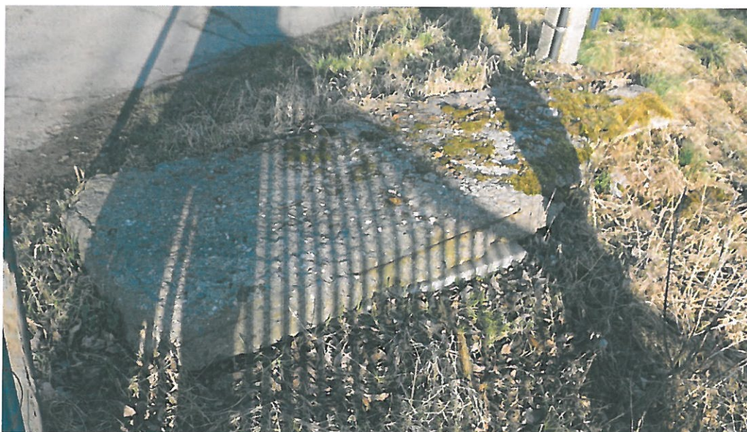
Fot. 33 Widoczna płyta betonowa na nasypie za obiektem od strony dojazdu z Katowic (strona północna). Płyta wykazuje brak stabilności a z jej nieregularnych krawędzi wystają miejscowo pręty zbrojeniowe stanowiące niebezpieczeństwo dla ruchu pieszych.
