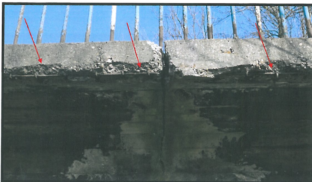
Fot. 28 Widoczne ubytki betonu, odsłonięte skorodowane zbrojenie, zacieki na gzymsie od strony południowej. Uszkodzenia spowodowane przeciekami wody przez nieuszczelną izolację w miejscu dylatacji wspornika płyty. Zaleca się wykonanie szczelnej izolacji i dylatacji oraz naprawę powierzchniową betonu z wykonaniem zabezpieczenia antykorozyjnego betonu.
