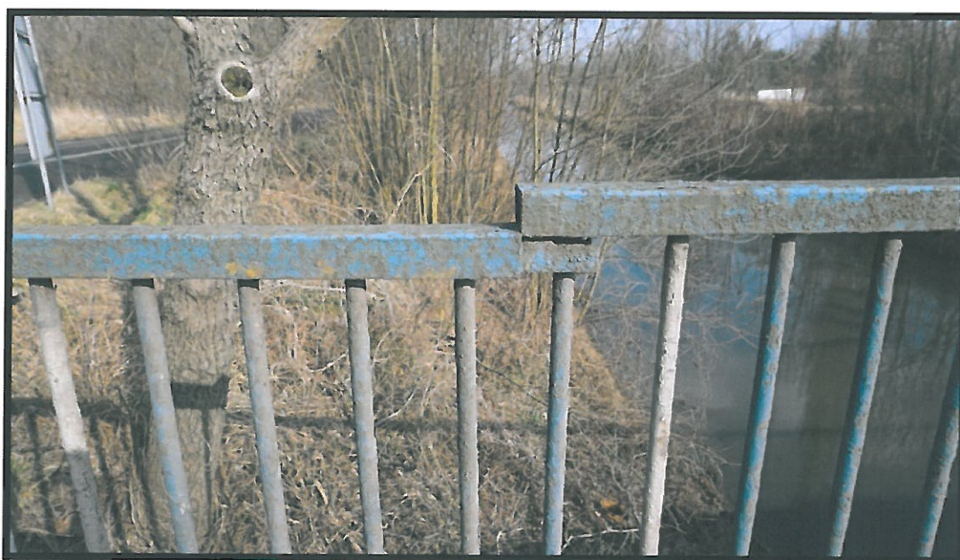
Fot. 19 Widoczny brak ciągłości pochwyty balustrady zabudowanej na północnym gzymsie mostu. Zaleca się naprawę (wymianę) balustrady stalowej.
