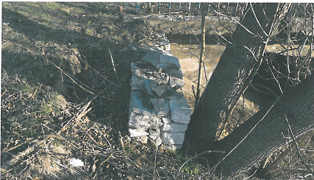
Fot. 32 Uszkodzenie jw. Dodatkowo ubytki kamienia od strony Katowic (strona południowa).
