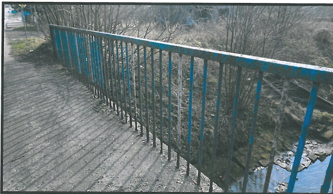
Fot. 16 Widoczne zniszczenie zabezpieczenia antykorozyjnego balustrady od strony południowej na całej długości spowodowane naturalnym zużyciem i stosowaniem środków odladzających w okresie zimowym. Zaleca się wykonanie kompleksowego remontu balustrady poprzez wymianę istniejącej balustrady na nową.
