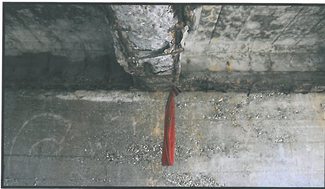
Fot. 23 Wspornik od strony Sosnowca: Uszkodzenie jw.
