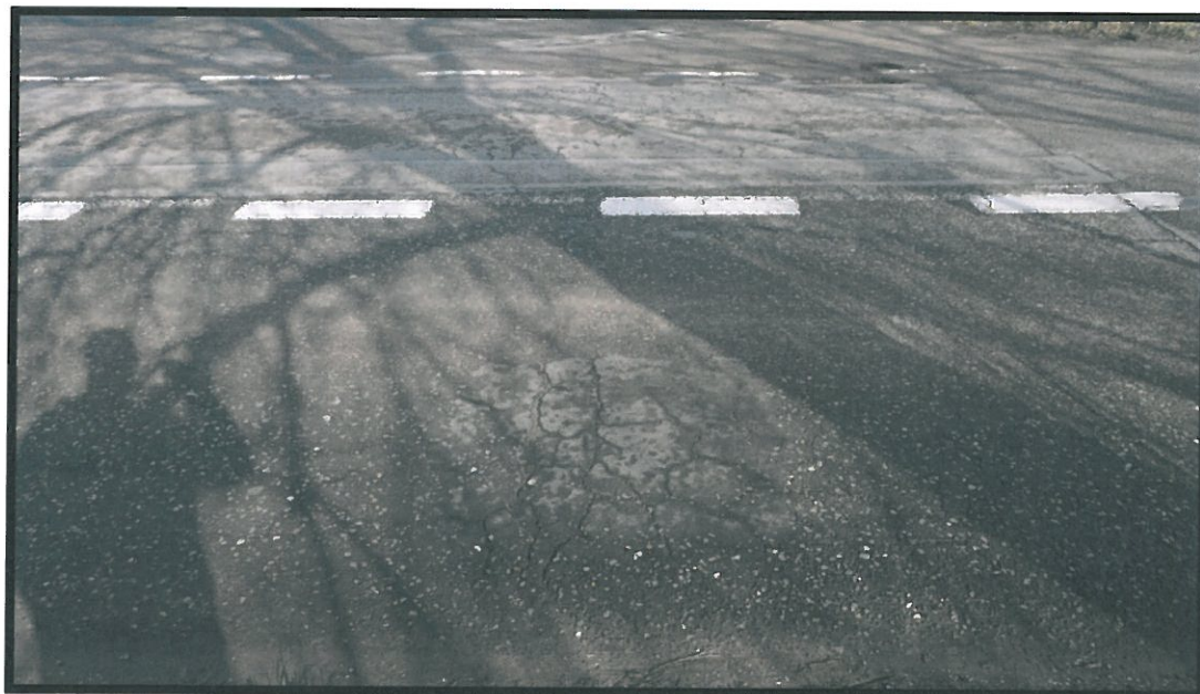
Fot. 7 Miejscowe spękanie nawierzchni asfaltowej na dojeździe od strony Katowic spowodowane słabą jakością mieszanki asfaltowej oraz naturalnym zużyciem.
