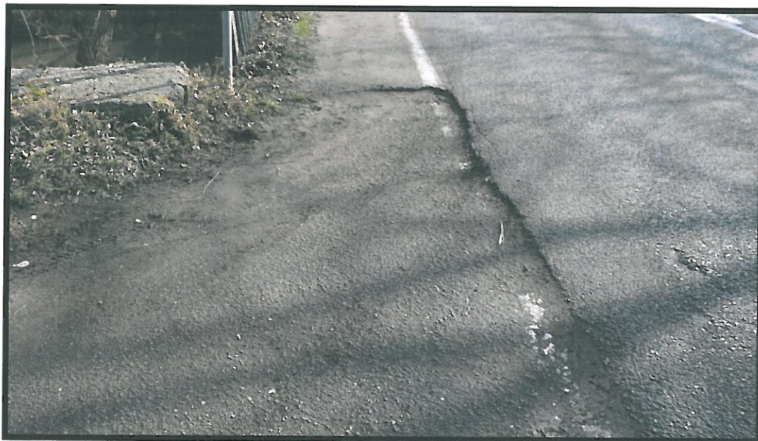
Fot. 14 Deformacje nawierzchni na poboczu od strony Katowic (strona północna) spowodowane niewłaściwym wykonaniem połączenia nawierzchni łączących się dróg.
