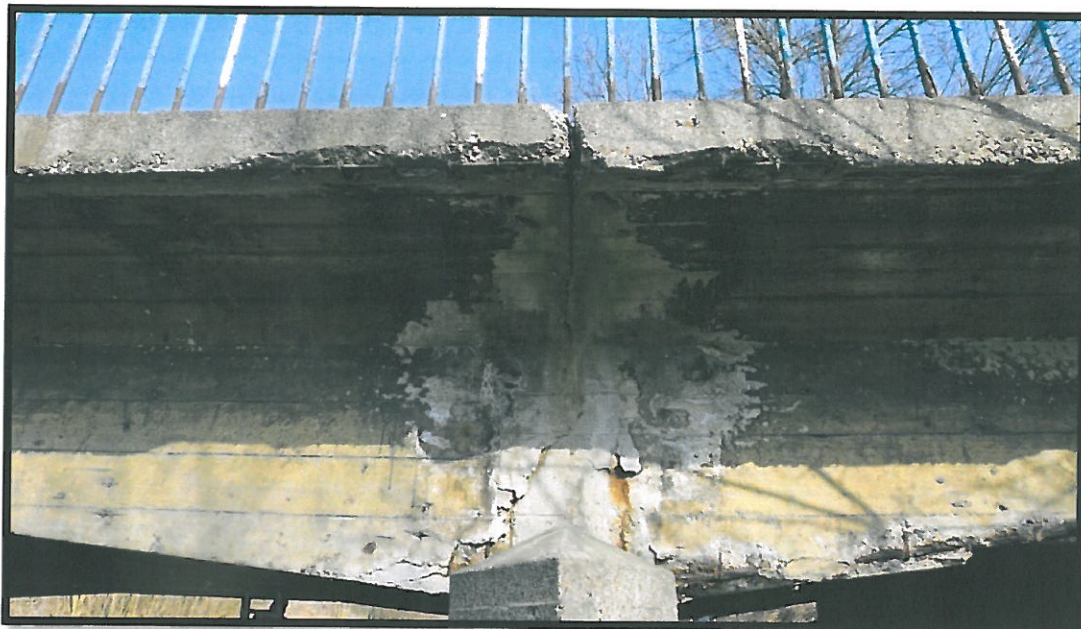
Fot. 20 Widoczne ubytki betonu, odsłonięte skorodowane zbrojenie, zacieki, osady na bocznej powierzchni ustroju nośnego od strony południowej (dolna woda). Uszkodzenia spowodowane przeciekami wody przez nieszczelną izolację w miejscu dylatacji wspornika płyty.
