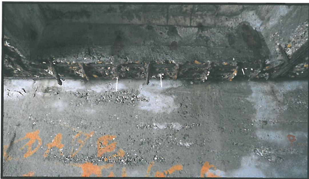
Fot. 22 Wspornik od strony Katowic: Bardzo duże ubytki betonu, odsłonięte skorodowane zbrojenie oraz zacieki na poprzecznicy wspornika ustroju nośnego. Uszkodzenia są wynikiem przede wszystkim brakiem szczelności styku dylatacyjnego na końcu wspornika mostu.
