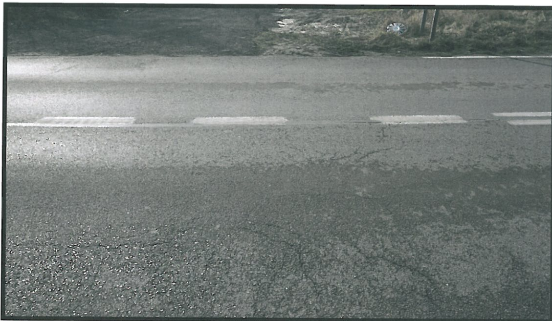
Fot. 6 Miejscowe spękanie nawierzchni asfaltowej na dojeździe od strony Sosnowca spowodowane słabą jakością mieszanki asfaltowej oraz naturalnym zużyciem.
