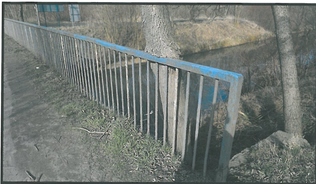
Fot. 18 Widoczne wrastanie drzewa w balustradę od strony Sosnowca (strona północna) spowodowane brakiem robót utrzymaniowych. Zaleca się wycięcie drzewa kolidujących z konstrukcją mostu i jego wyposażeniem.
