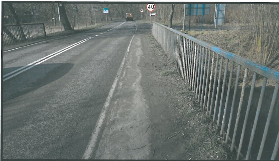
Fot. 10. Wegetacja roślinności, zanieczyszczenia na poboczu od strony północnej spowodowane niewłaściwym utrzymaniem obiektu. Zaleca się oczyszczenie z zanieczyszczeń i roślinności.
