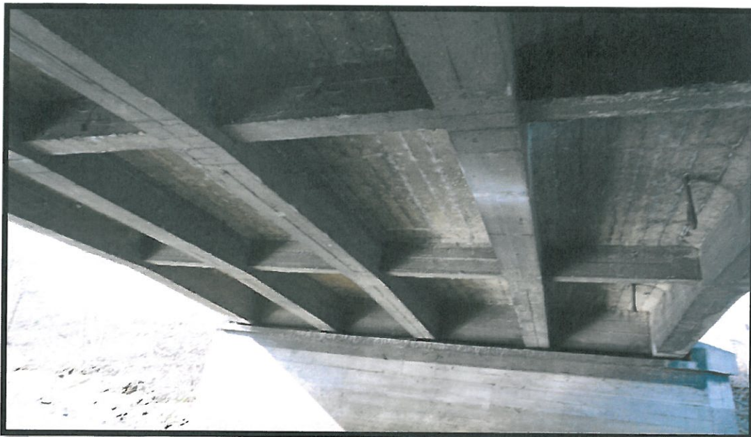
Fot. 5 Widok spodu konstrukcji. Konstrukcja nośna mostu wykonana z pięciu dźwigarów żelbetowych połączonych monolityczną płytą.
