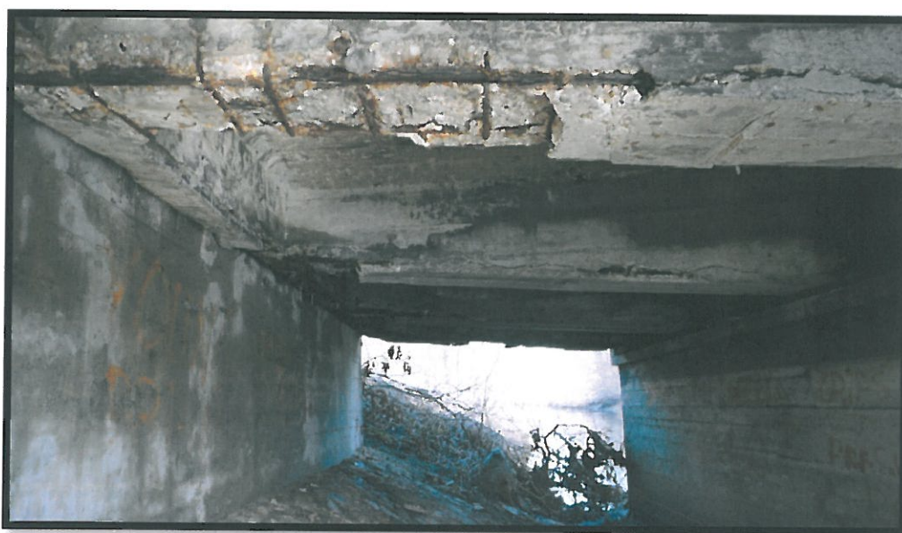
Fot. 21 Wspornik od strony Katowic: Bardzo duże ubytki betonu, odsłonięte skorodowane zbrojenie oraz zacieki na dźwigarze wspornika. Uszkodzenia są wynikiem barku szczelnej izolacji płyty pomostu oraz przede wszystkim całkowitej nieszczelności styku dylatacyjnego.
