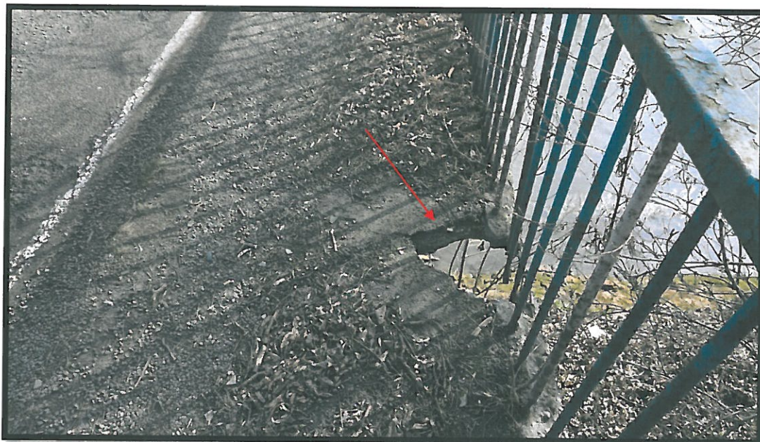
Fot. 12 Bardzo duży ubytek nawierzchni i betonu wspornika płyty, odsłonięte skorodowane zbrojenie, zanieczyszczenia na poboczu od strony południowej spowodowane nieuszczelnnością izolacji, niewłaściwym utrzymaniem obiektu, złą jakością betonu oraz brakiem odpowiednich spadków. Zaleca się pilną naprawę ustroju nośnego ze względu na zagrożenie ruchu pieszego, uszkodzenie należy naprawić do końca czerwca 2020r.
