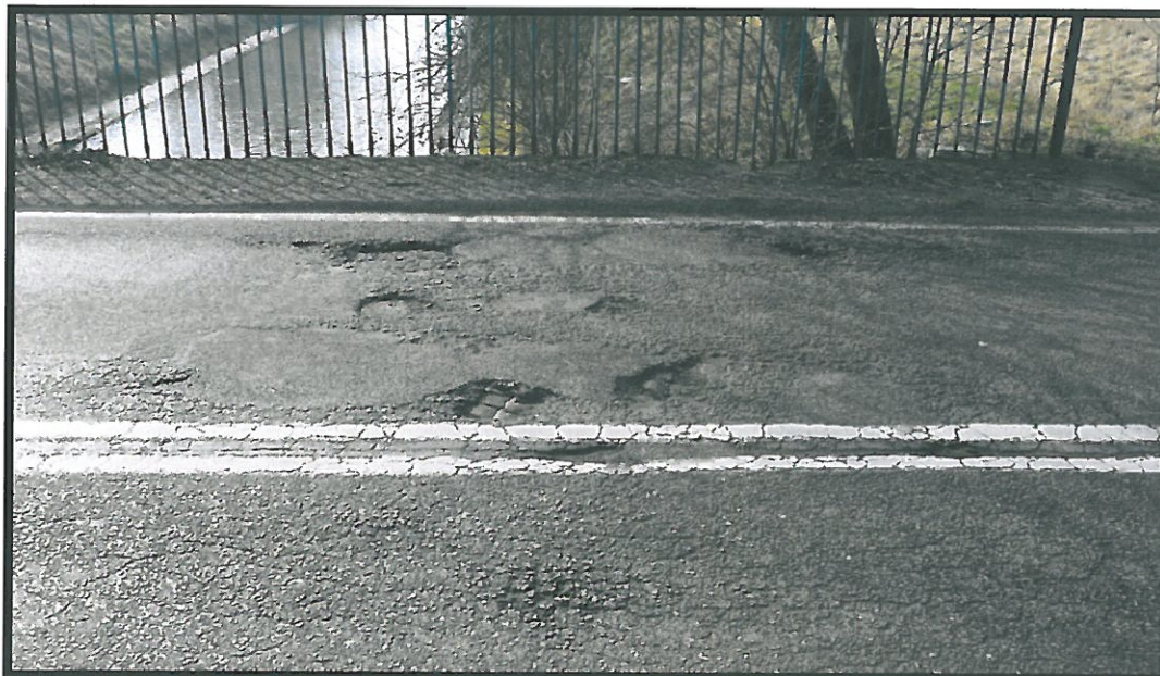
Fot. 8 Widoczne pęknięcia i duże ubytki nawierzchni asfaltowej jezdni na obiekcie spowodowane brakiem robót utrzymaniowych, słabą jakością mieszanki asfaltowej oraz naturalnym zużyciem.
