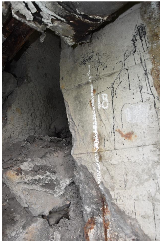
Fot. 11. Znaczne ubytki betonu na dźwigarze w rejonie podparcia. Ubytki betonu na ścianie zapleczej.
