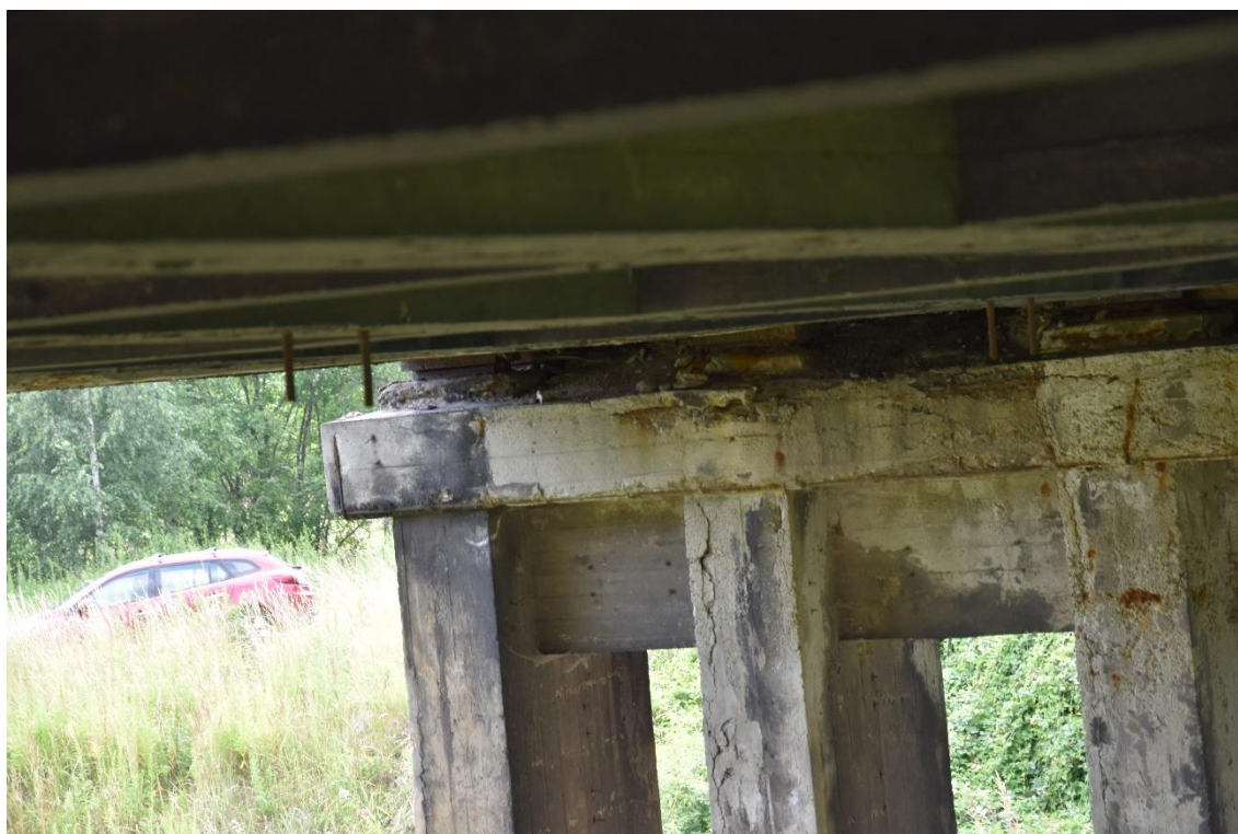
Fot. 12. degradacja oczepu oraz filarów podpory pośredniej. Korozja łożysk.
