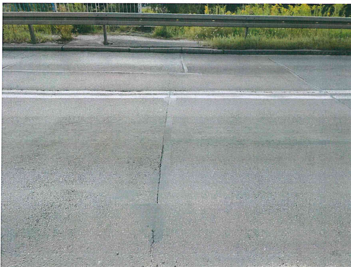
Fot. 22. Deformacje nawierzchni w rejonie szczeliny dylatacyjnej.
