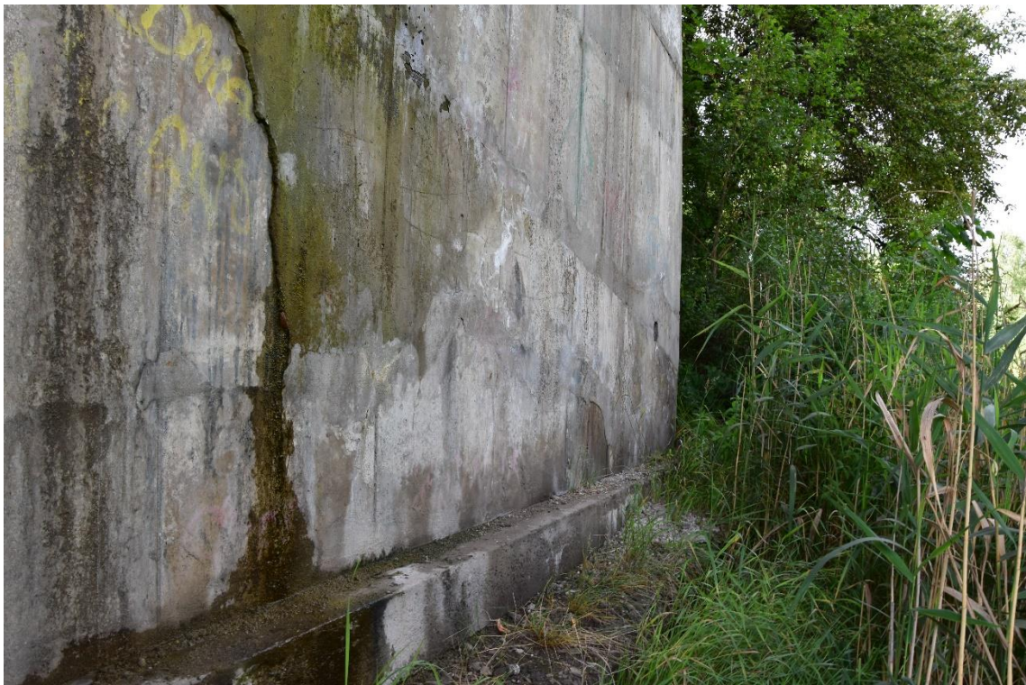
Fot. 16. Ubytek betonu na skrzydełku. Zacieki, wegetacja roślin.
