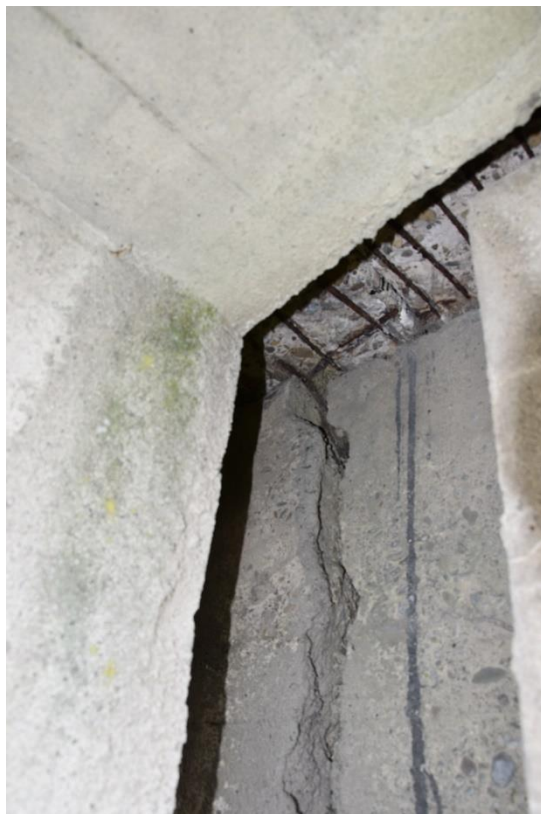
Fot. 8. Pęknięcie ściany zapleczej, przemieszczenie elementów betonowych. Ubytki betonu i korozja stali zbrojeniowej.
