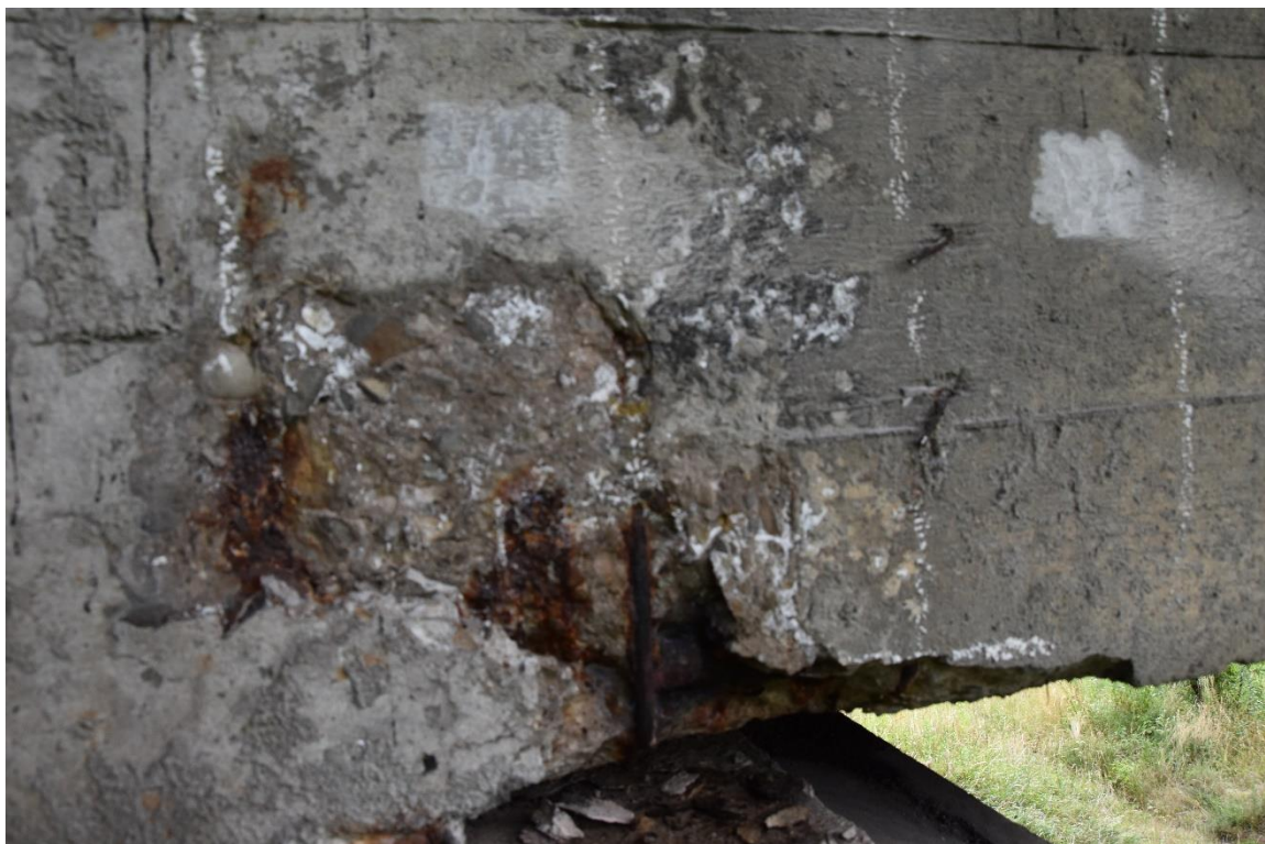
Fot. 10. Głębokie ubytki betonu nad łożyskiem, korozja stali zbrojeniowej.
