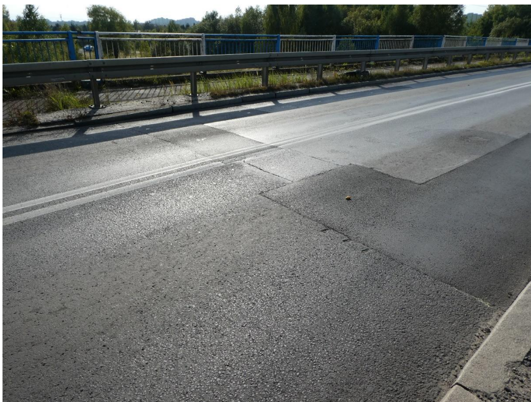
Fot. 22. Deformacje nawierzchni w rejonie szczeliny dylatacyjnej.
