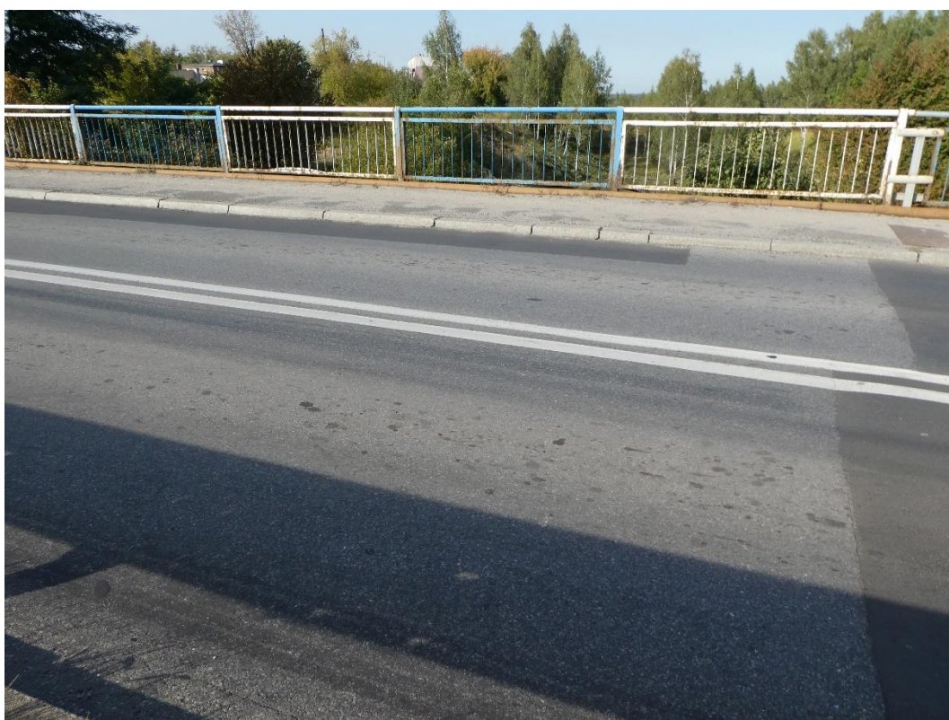
Fot. 20. Nawierzchnia jezdni. Deformacje w postaci kolein na całej długości obiektu.
