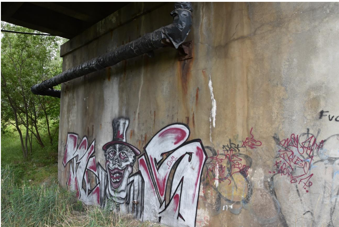
Fot. 2. Zarysowanie betonu na przyczółku, korozja stali zbrojeniowej i rdzawe zacieki.
