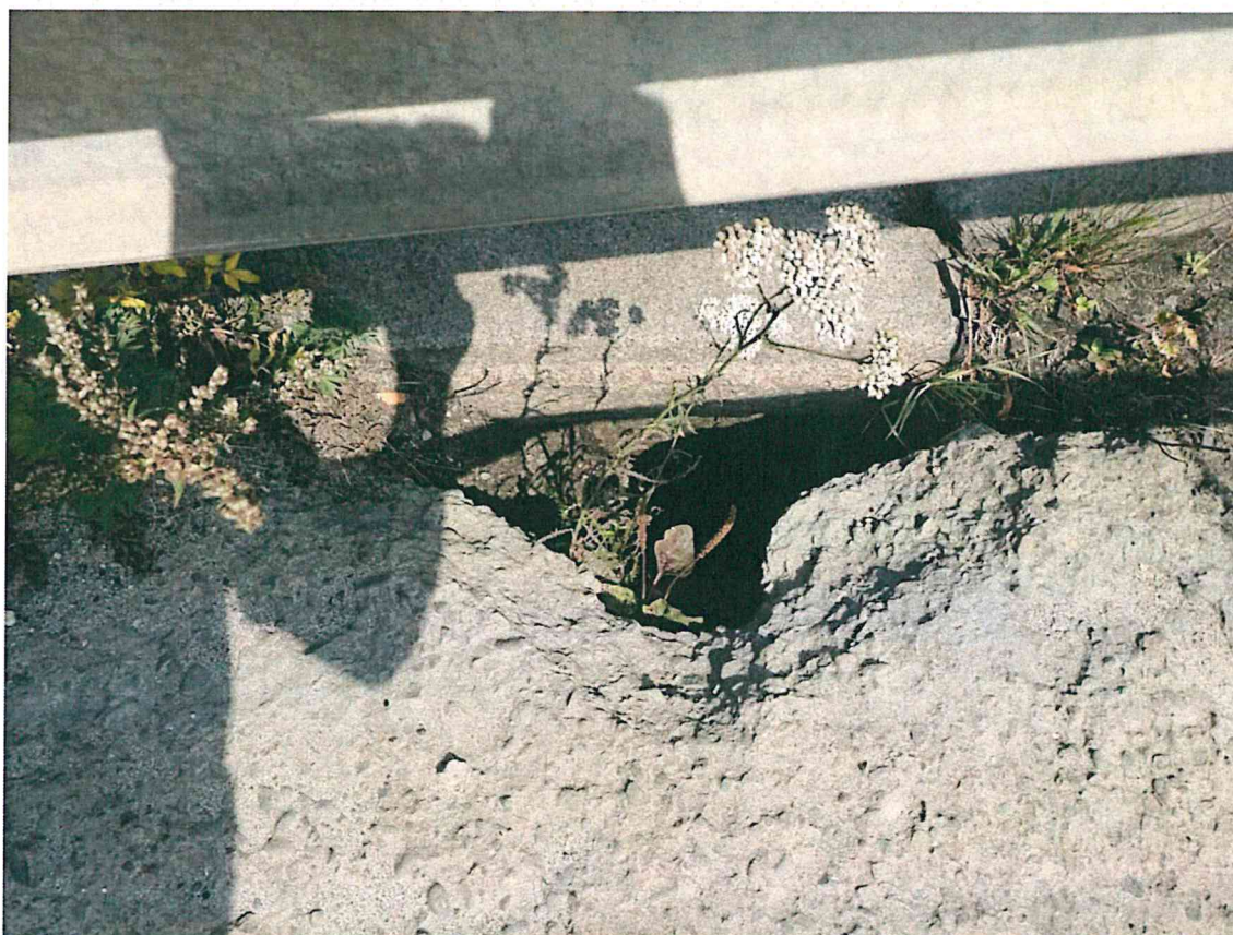
Fot. 18. Ubytek betonu kapy chodnikowej i płyty pomostowej. Przez otwór widoczny teren pod obiektem.
