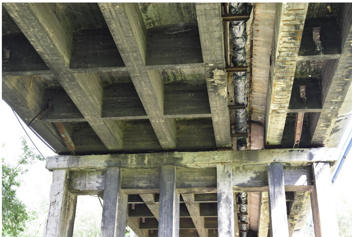
Fot. 3. Korozja betonu na podporze pośredniej. Korozja strzemion na dźwigarach. Znaczne ubytki betonu na dźwigarach i podporze pośredniej.
