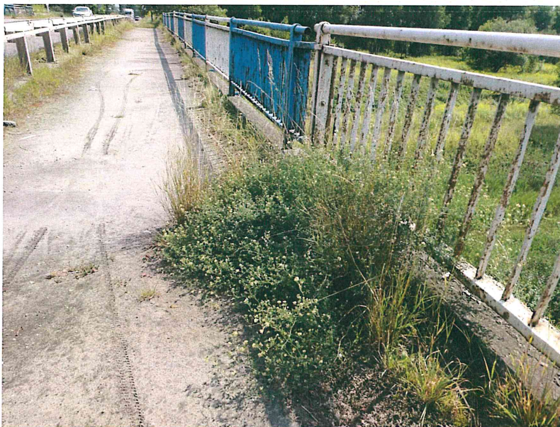
Fot. 21. Deformacja nawierzchni chodnika, znaczne zanieczyszczenia i wegetacja roślin. Widoczne naniesienie gruntu po tworzących się zastoiskach wody.
