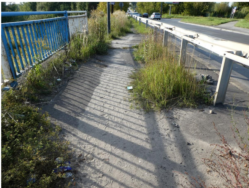
Fot. 21. Deformacja nawierzchni chodnika, znaczne zanieczyszczenia i wegetacja roślin. Widoczne naniesienie gruntu po tworzących się zastoiskach wody.
