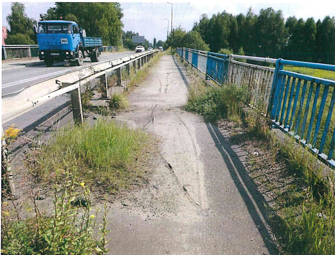
Fot. 17. Nawierzchnia chodnika. Widoczne zanieczyszczenia, wegetacja roślin, deformacje nawierzchni ślady po zastoiskach wody.
