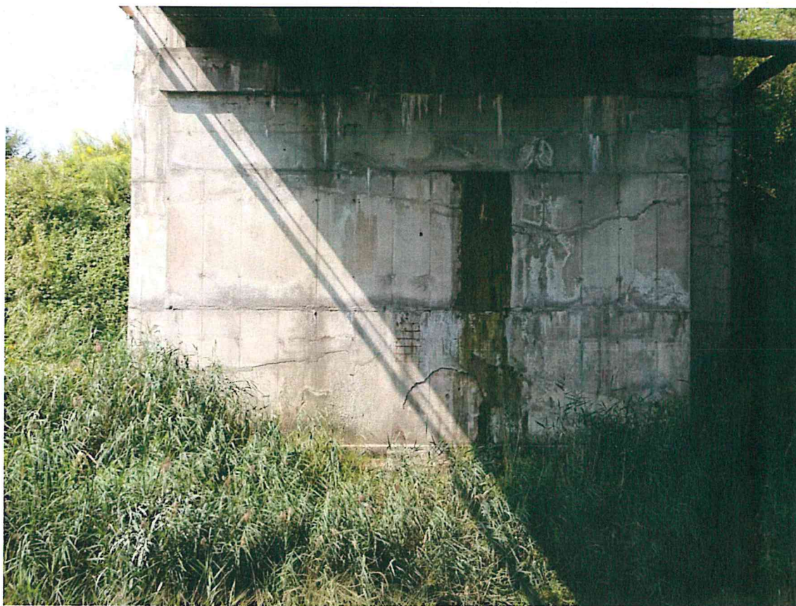
Fot. 9. Przecieki przez przyczółek. Degradacja betonu na przyczółku.
