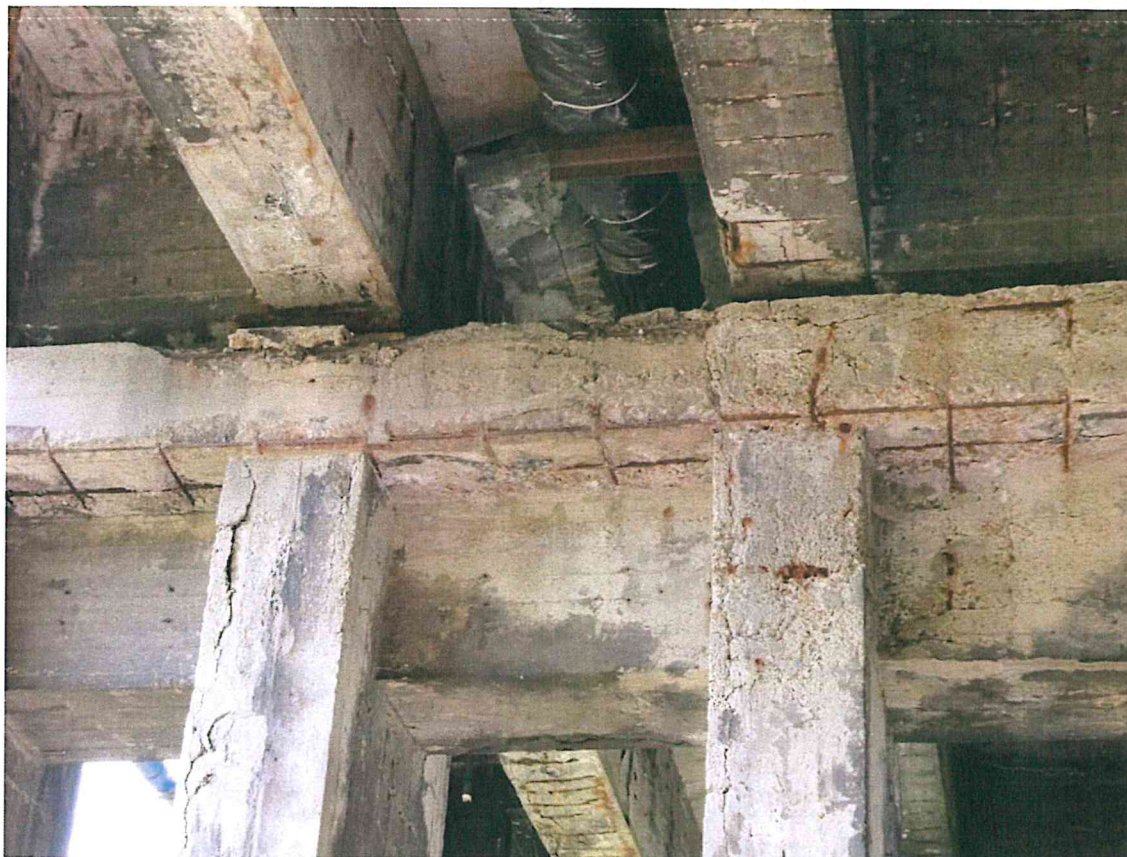
Fot. 3. Korozja betonu na podporze pośredniej. Korozja strzemion na dźwigarach. Znaczne ubytki betonu na dźwigarach i podporze pośredniej.
