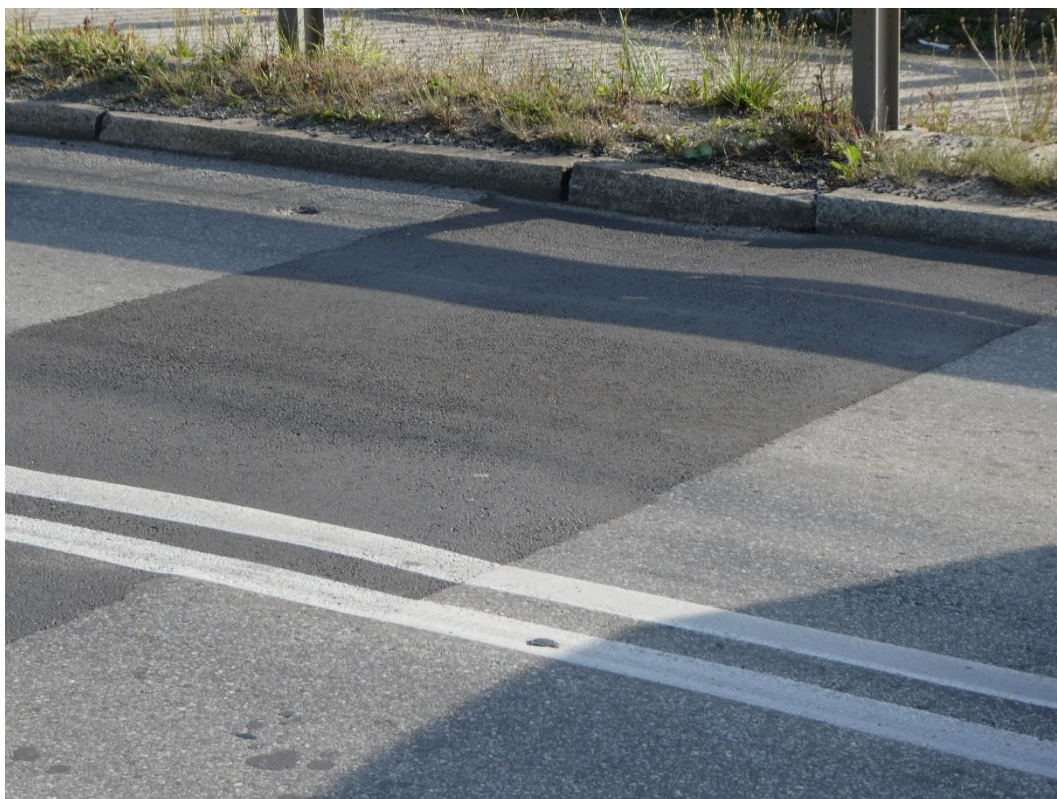
Fot. 23. Deformacja nawierzchni i przemieszczenie krawężnika nad szczeliną dylatacyjną.
