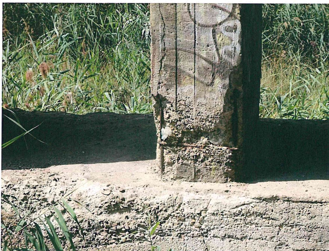
Fot. 4. Ubytki betonu i korozja stali zbrojeniowej u podstawy filara.
