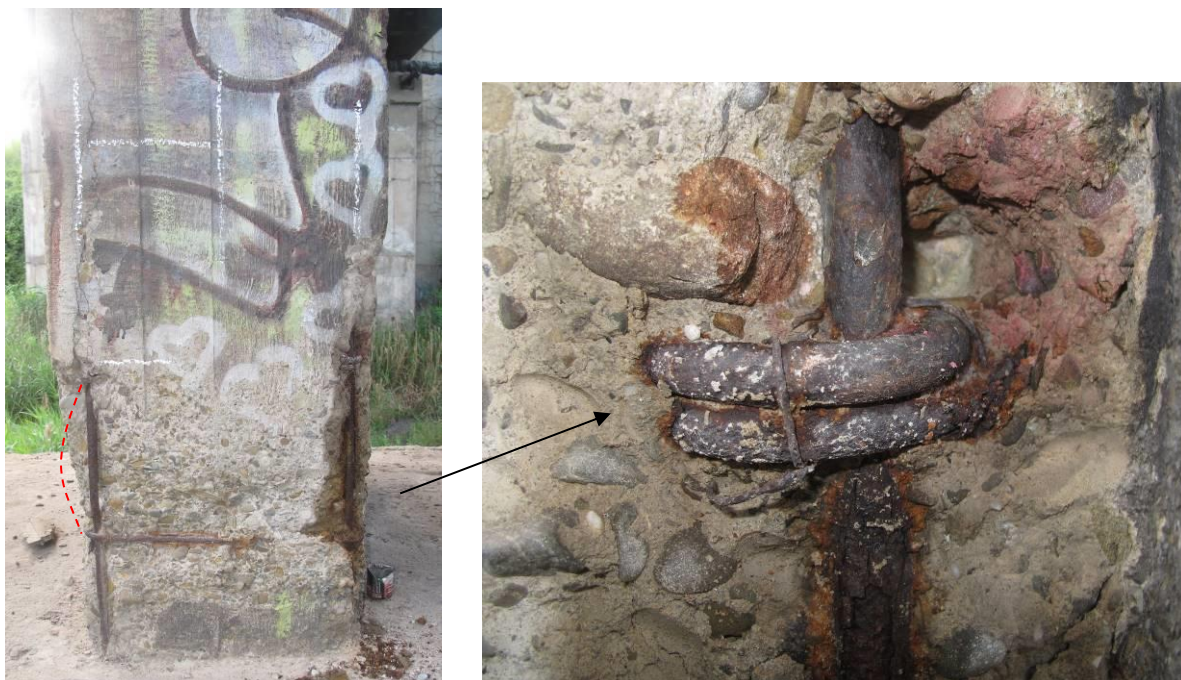
Fot. 7.3 Słup filara P2 – rozległe ubytki betonu otuliny w dolnych partiach słupów i górnej powierzchni ławy fundamentowej, deformacja prętów głównych w miejscach ubytków otuliny, miejscowe ubytki betonu do głębokości 5÷8 cm
