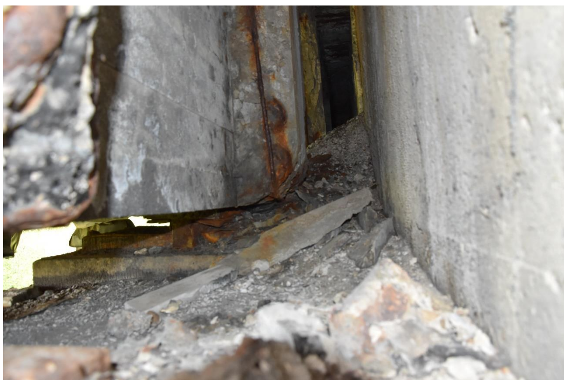
Fot. 4. Widok na przestrzeń między ustrojem i ścianą zapleczną. Znaczne zanieczyszczenie ławy podłożyskowej, korozja stali łożyska i korozja stali zbrojeniowej poprzecznicy. Degradacja betonu na poprzecznicy i ścianie zapleczonej.
