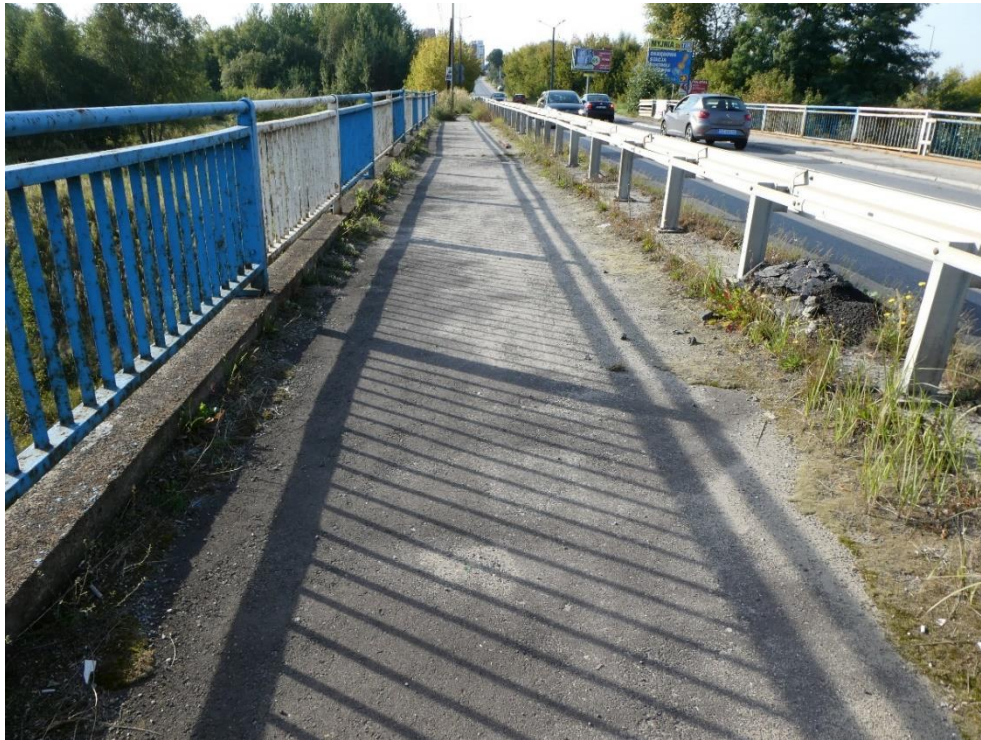
Fot. 17. Nawierzchnia chodnika po stronie południowej. Widoczne zanieczyszczenia, wegetacja roślin, deformacje nawierzchni ślady po zastoiskach wody.
