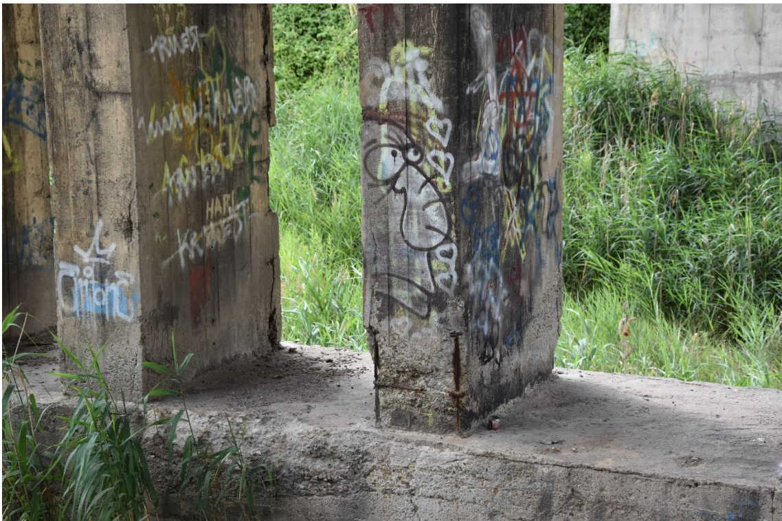
Fot. 6. Korozja i ubytki betonu na słupie podpory pośredniej. Korozja stali zbrojeniowej.
