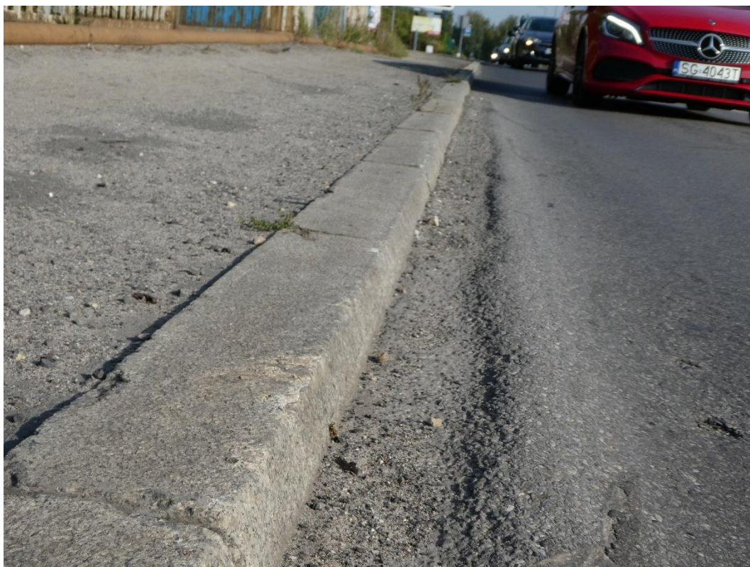
Fot. 19. Deformacja nawierzchni jezdni, krawężnik o zbyt małym wyniesieniu.
