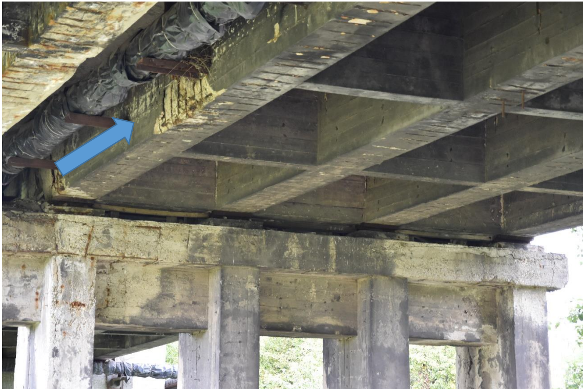
Fot. 5. Znaczne ubytki betonu na dźwigarze. Korozja stali zbrojeniowej.
