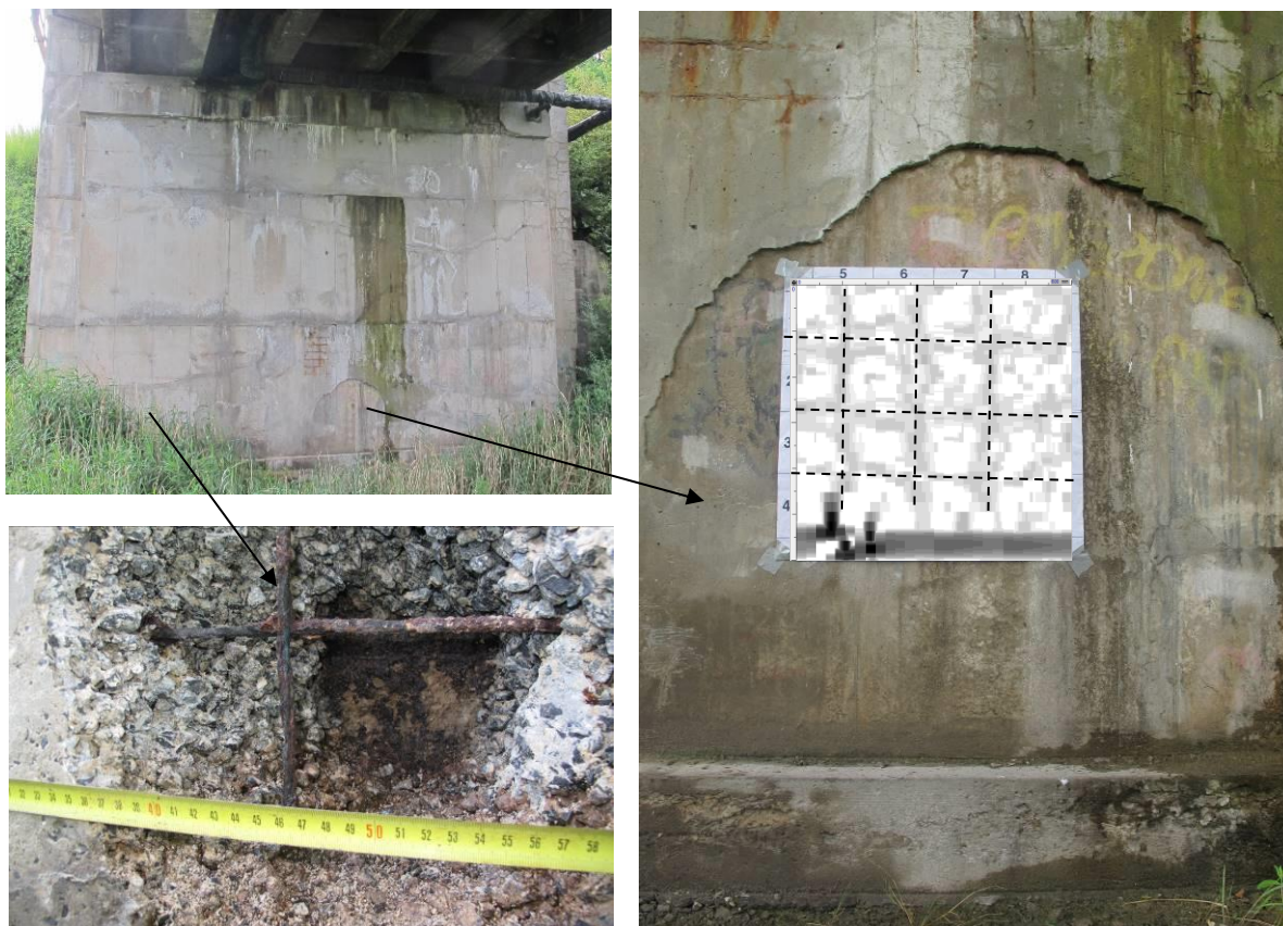
Fot. 7.2 Przyciótek P3 – po prawej obraz skanowania zbrojenia płaszcza żelbetowego w miejscu rozległego ubytku warstwy wierzchniej, po lewej miejscowy ubytek betonu na pełną grubość płaszcza (rozsegregowanie kruszywa, wilgoć pod płaszczem)
