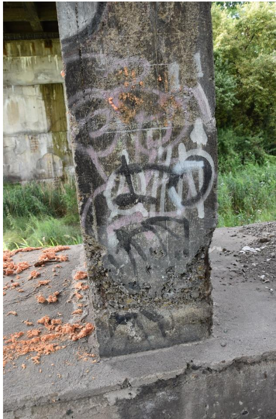
Fot. 15. Znaczne ubytki betonu oraz korozja stali zbrojeniowej filaru u jego podstawy.
