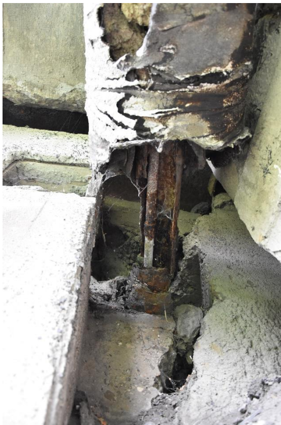
Fot. 13. Całkowita degradacja osłon urządzeń obcych na obiekcie.
