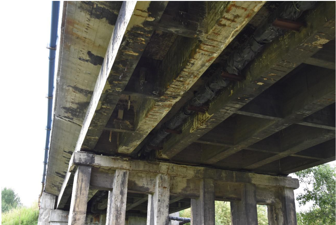
Fot. 1. Widok na ustrój nośny. Korozja prętów zbrojeniowych, ubytki i korozja betonu na powierzchni dźwigarów i podpory pośredniej.
