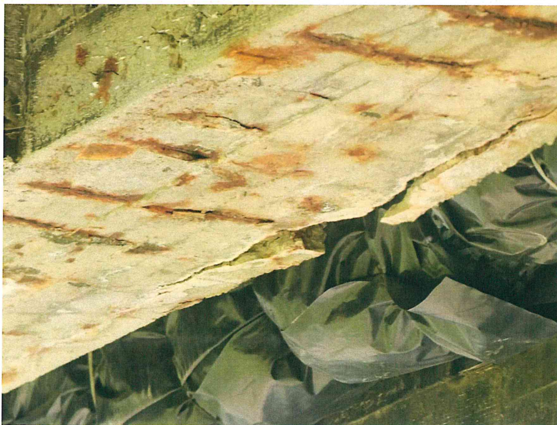
Fot. 10. Znaczne ubytki betonu na dźwigarze.
