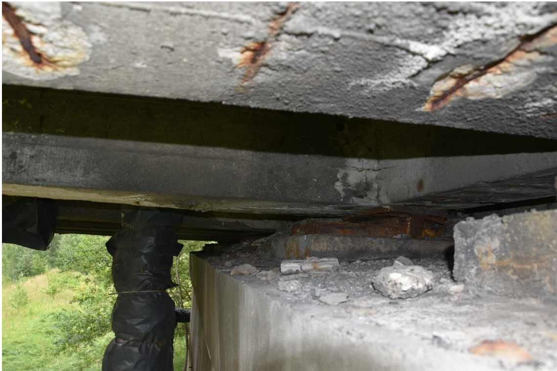
Fot. 9. Korozja stali łożysk. Korozja stali na dźwigarach.
