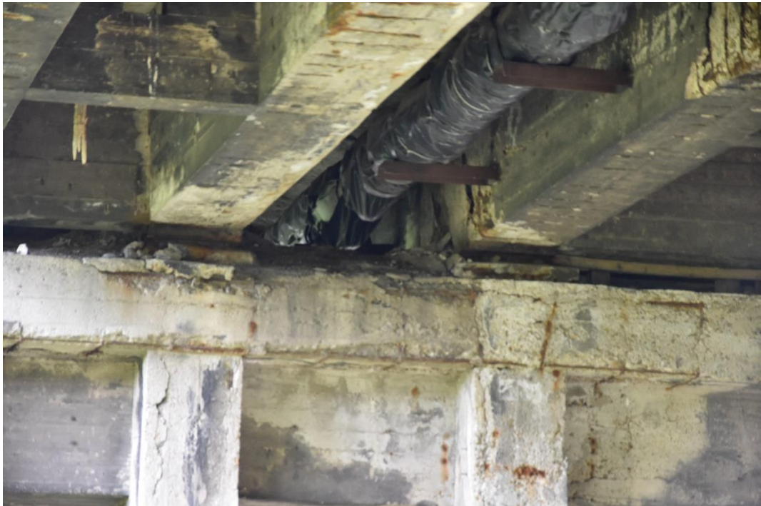
Fot. 7. Zaawansowana korozja betonu na powierzchni filara. Znaczne wykwyty i osady na całej powierzchni.
