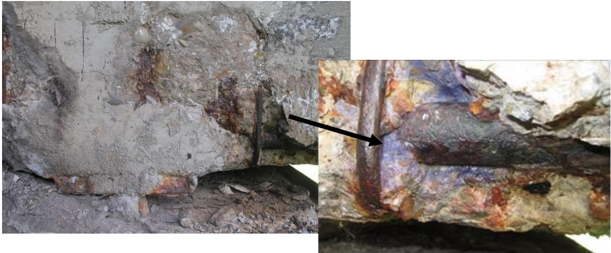
Fot. 7.1 Belka B6 nad przyczółkiem P1 - zaawansowana korozja zbrojenia w miejscu rozległego ubytku i odspojenia otuliny betonowej wzdłuż dolnej krawędzi belki
