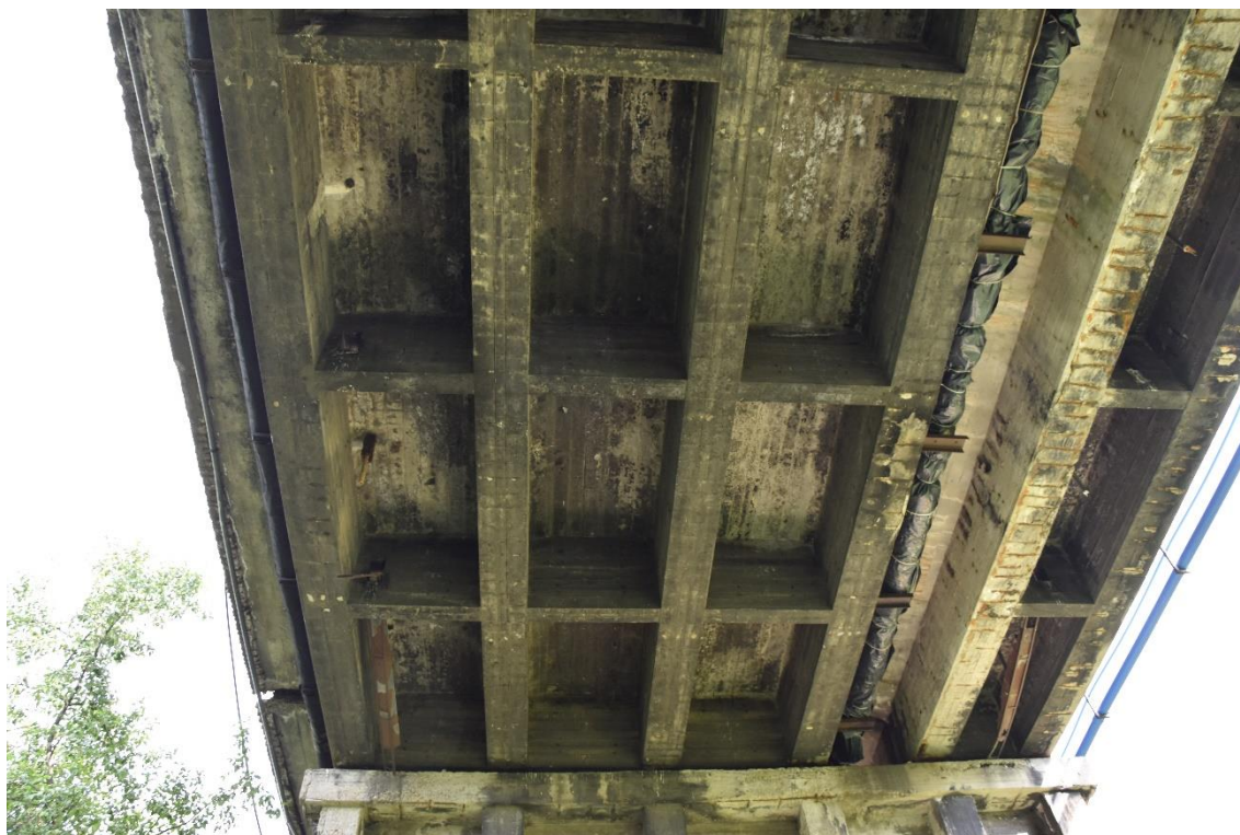
Fot. 14. Osady i przecieki na powierzchni płyty pomostowej. Widoczne odsłonięte strzemiona.
